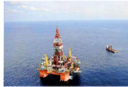
中国海洋石油钻井平台 CNOOC drilling platform
